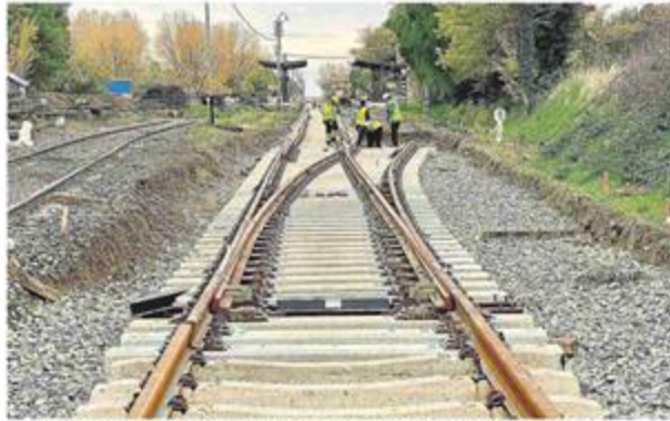
La renovación del tramo entre Planencia del Monte y Ayerbe, uno de los tramos pendientes, terminó a finales del año pasado.
